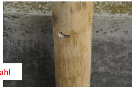
Idealerweise sollten die Löcher spiegelverkehrt, unter einem Winkel von  $45^\circ$  angeordnet sein. Somit ergibt sich eine optimale Anordnung des Spanndrahtes (siehe Bild unten).
