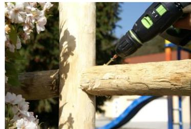
14) Löcher an den Markierungen der Drahtreihen mit  $\varnothing 6\text{mm}$ -bohren und von beiden Seiten aufsenken.
