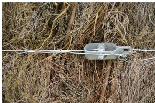
24) Damit der Zaun sauber und stabil anliegt, alle Drähte über den Drahtspanner mit 8mm-Gabelschlüssel spannen.
