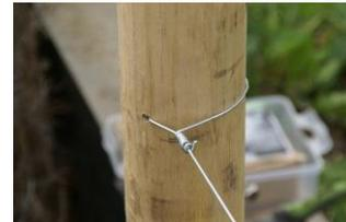
18) Die kürzere Drahtseite (60cm) durch die Öse des Drahtspanners einfädeln, diesen bei ca.50cm positionieren und das übrige Ende umwickeln.
