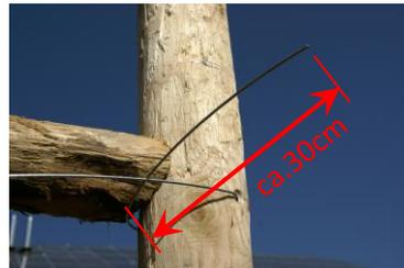
Anschließend den Draht auf das Maß „Verstrebungslänge minus 30cm“ kürzen (siehe Bild unten).
