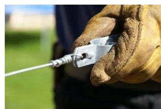
19) Die längere Drahtseite durch die stirnseitige Öse und Rastbolzen des Drahtspanners einfädeln. Anschließend den Draht mit einem 8mm-Gabelschlüssel einige Male aufwickeln, bis der Draht leicht vorgespannt ist.
