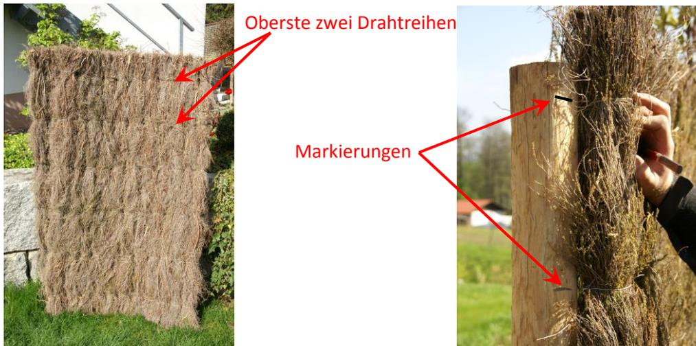
12) Verstrebung in die Mitte der obersten zwei Drahtreihen setzen und mit Holzschraube, z.B. 5,0 x 120 / 62, befestigen.
